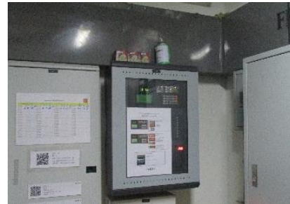
แผงควบคุมระบบแจ้งเหตุเพลิงไหม้ (Fire Alarm Control Panel ; FCP)
