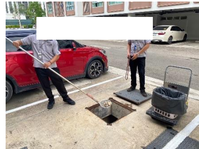
ภาพที่ 2-13 การตัดไขมันและน้ำมันออกจากถังดักไขมัน
