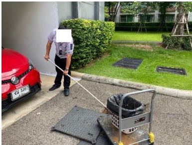
ภาพที่ 2-13 การตัดไขมันและน้ำมันออกจากถังดักไขมัน
