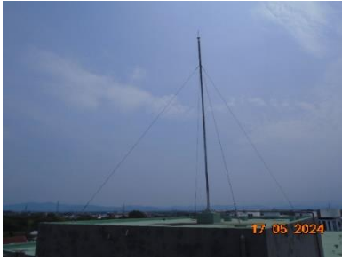
ภาพที่ 2-41 ระบบป้องกันฟ้าผ่าแบบสายล่อฟ้า
